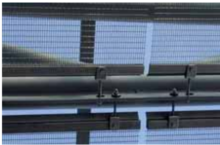
Spannen der Drahtgewebe-Elemente mittels Spannkante und Gabelschrauben
