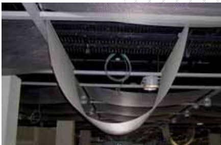
Revisionszustand des mit Schlitzprofil eingefassten Drahtgewebe-Elements
